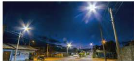
Av. Gonzales Prada - Madre de Dios, hoy cuenta con modernas luminarias LED
