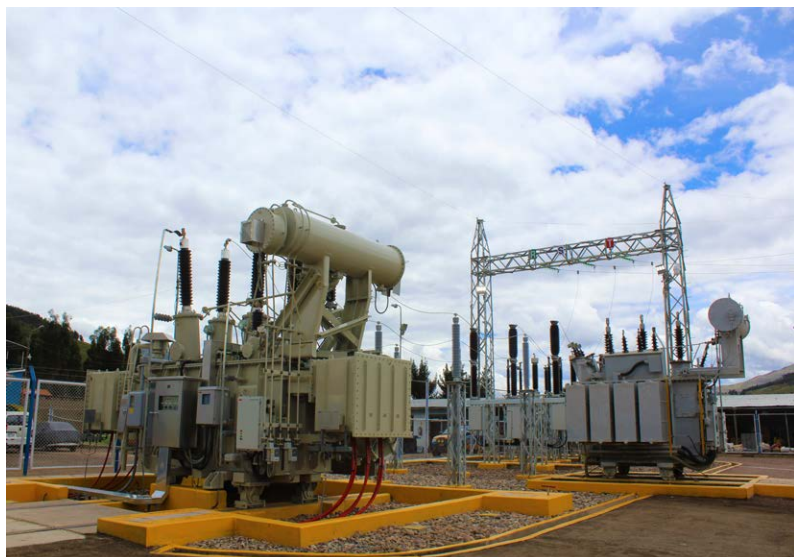
Renovado Transformador y Celdas 10 y 22.9 kV. de la Subestación de Sicuani - Canchis
