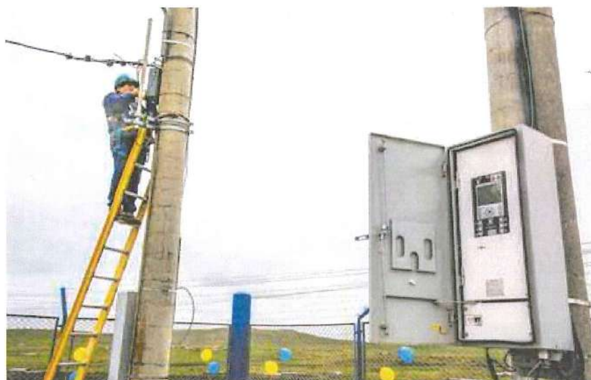
Energía para todos. La electrificación es un beneficio que ayuda al progreso de las familias.
