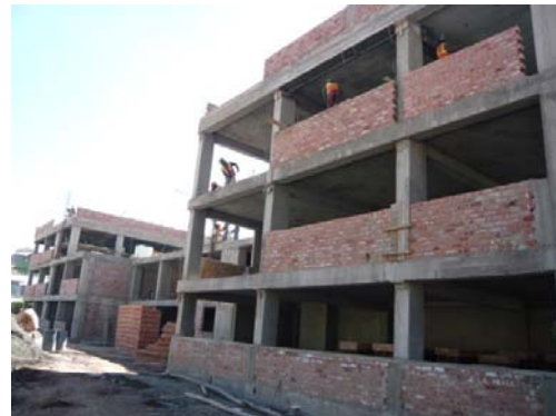
Edificio en construcción
